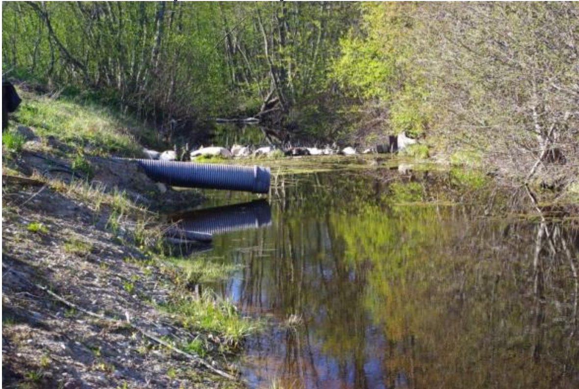
Lisa 2.3 Vee tõkestamine ja vanasse Vaskjala-Ülemiste kanalisse suunatud torud
