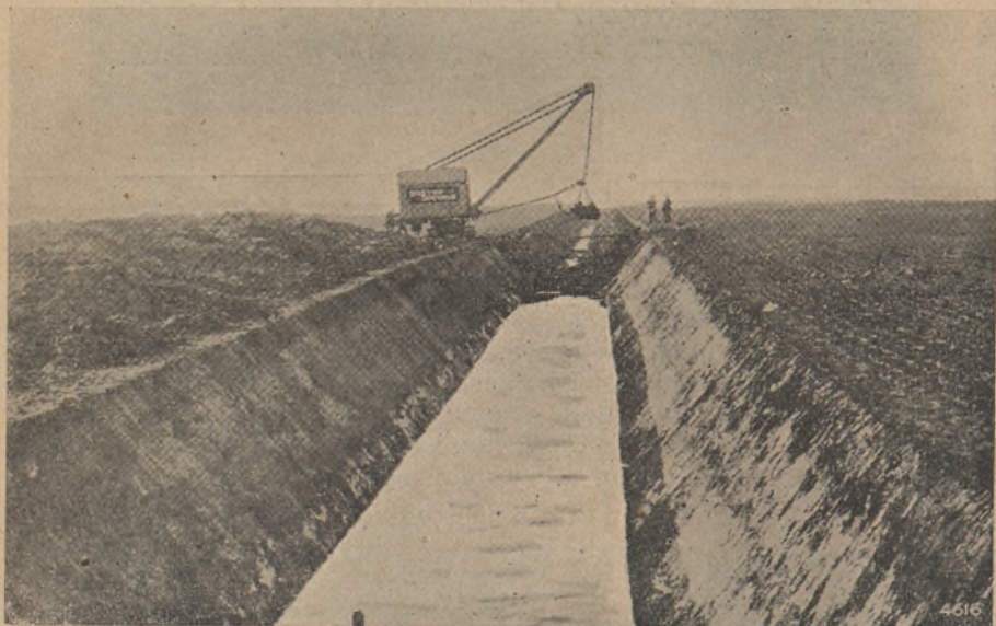
Pilt 25. Isesõitja bager magistraalkraavi puhastamas (Cambridge's — Inglismaal).
