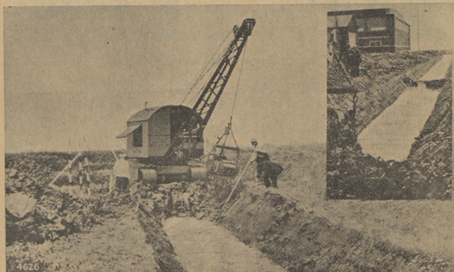
Pilt 24. Isesõitja bager magistraalkraavi kaevamisel Hollandis.
